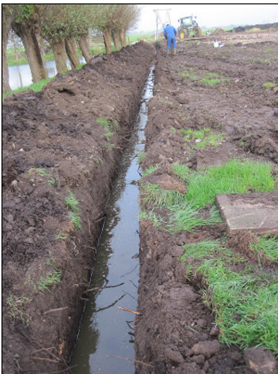
Afbeelding 8. Impressie van de gegraven leidingsleuf. De foto is genomen richting het noorden.
