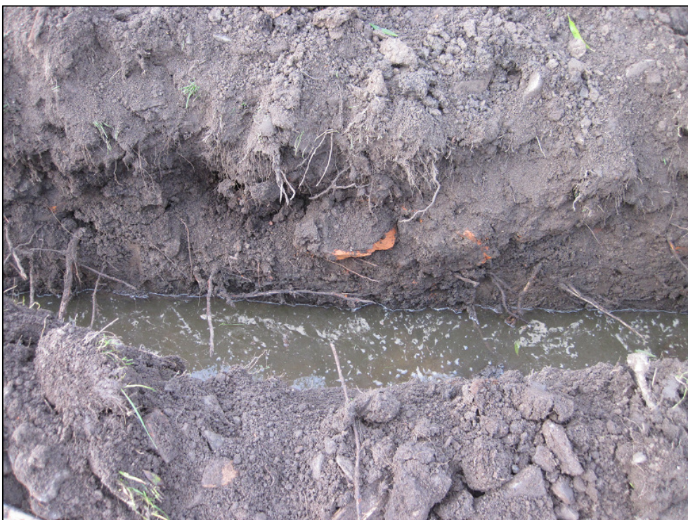
Afbeelding 9. Impressie van het profiel van de leidingsleuf. De foto is genomen richting het westen.
