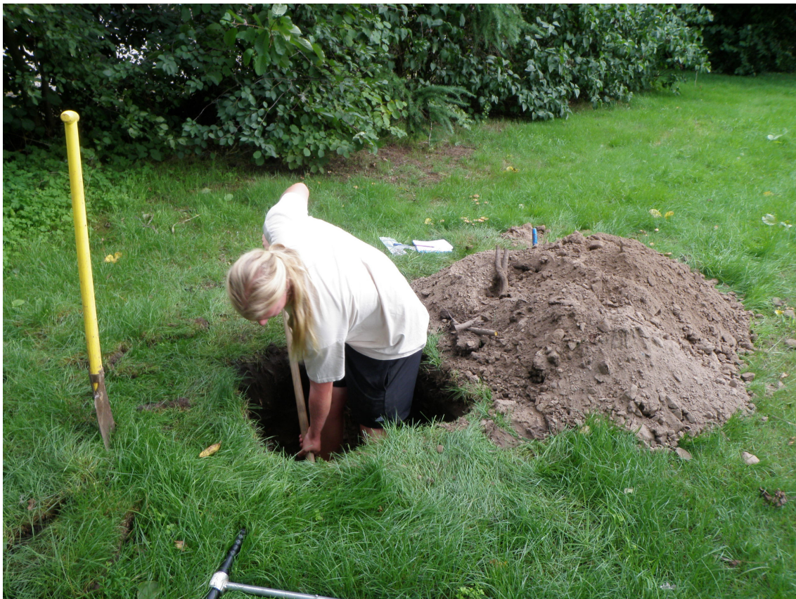
Figuur 14: Het graven van de proefput.
