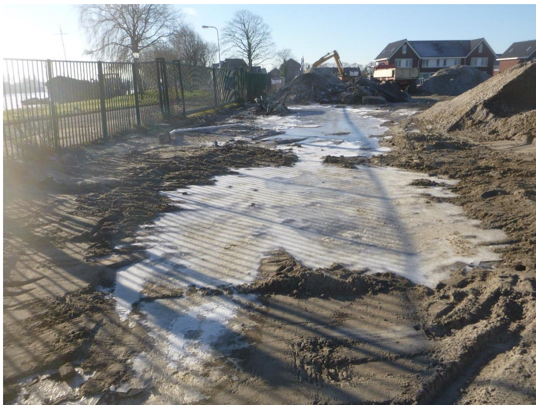
Afbeelding 13. Foto van de wateroverlast in de werkputten die in 2017 zijn aangelegd op het oostelijke deel van het terrein (foto: Antea Group).
