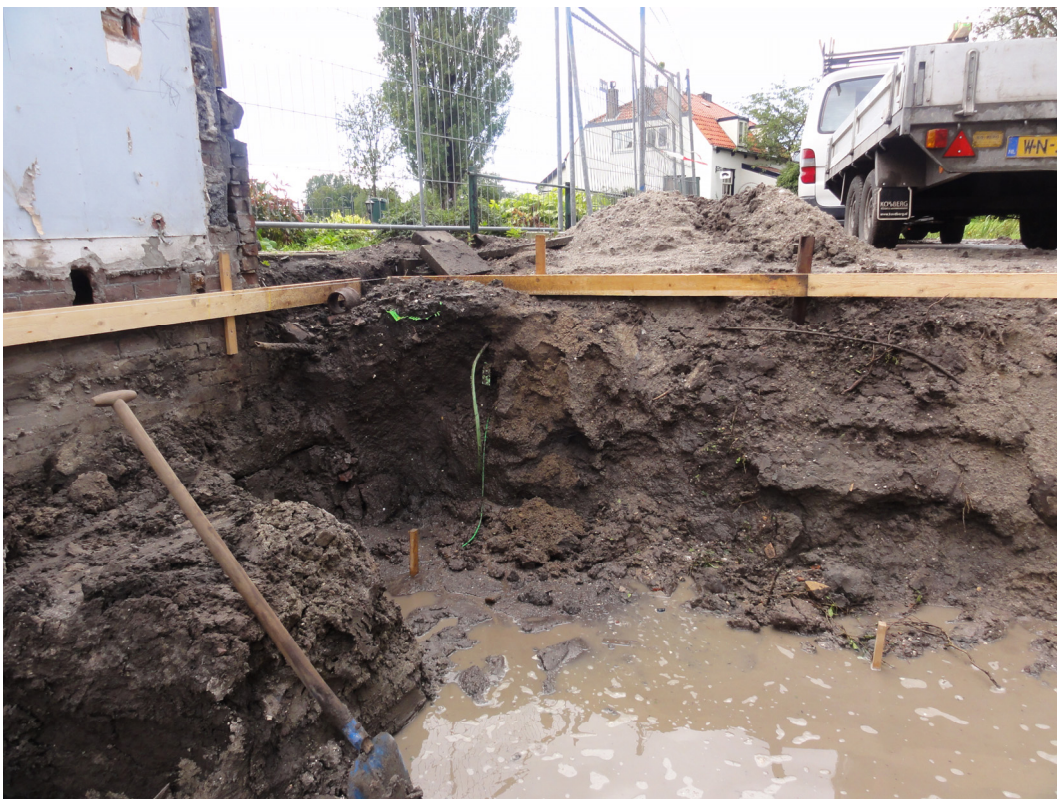
Afb. 5 Detail van de bouwput tijdens de sloop
