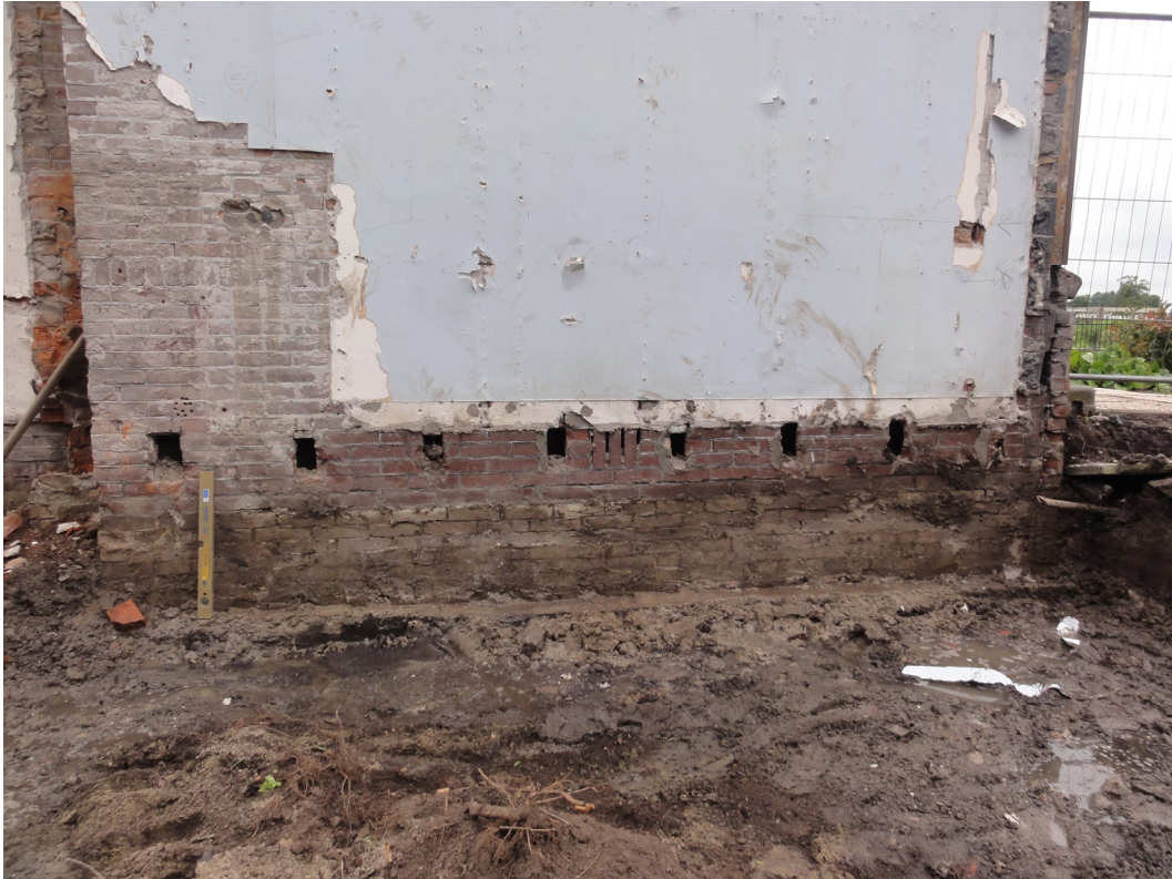
Afb. 6 Fundering van het aan het plangebied grenzende huis
