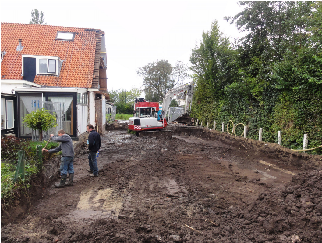
Afb. 4 Overzicht van de bouwput tijdens de sloop
