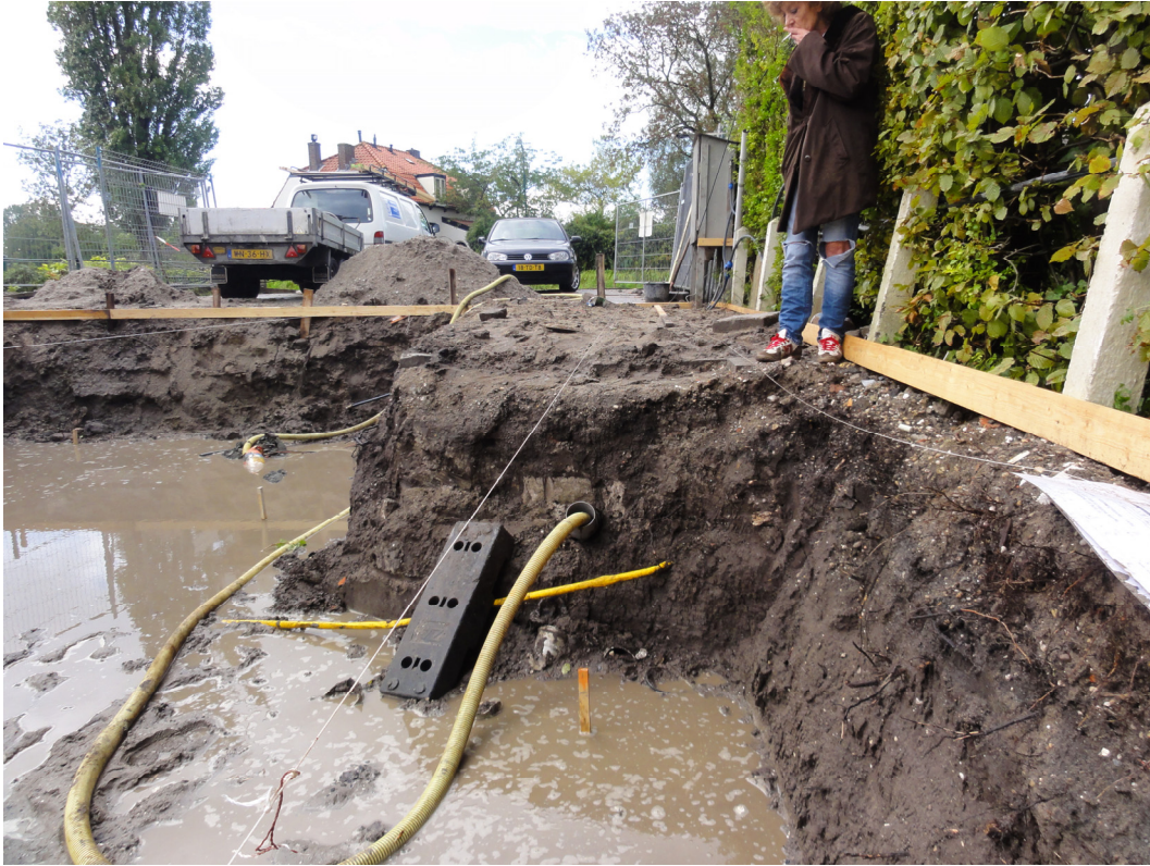
Afb. 8 Het riool naast de woning
