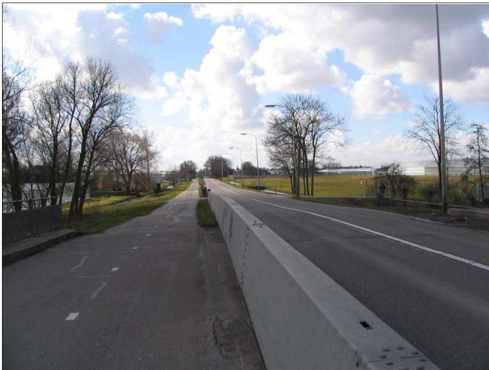
Figuur 4. Burg. van de Goeslaan (N223) in westelijke richting tussen de boringen 197 en 201.
