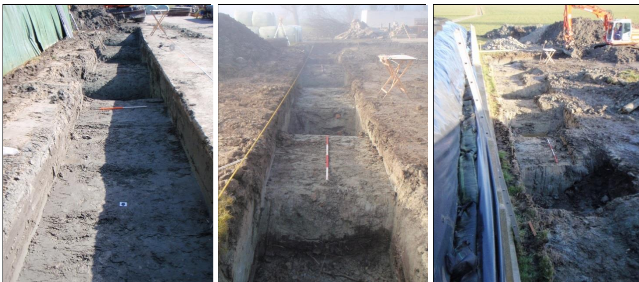
Afbeelding 7. Foto's met overzichten van de funderingssleuven: links de westelijke funderingssleuf, midden de zuidelijke funderingssleuf en rechts de oostelijke funderingssleuf
