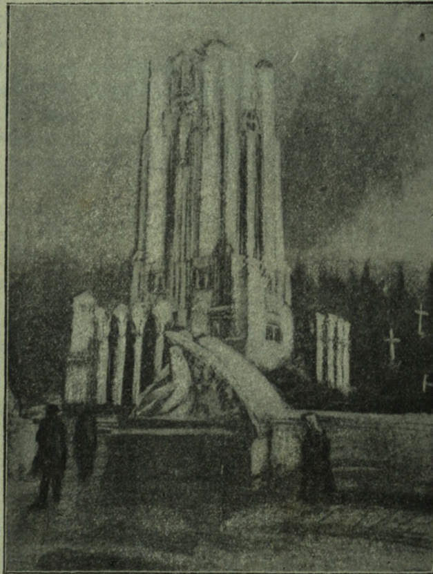
Kaplica w Szydłowie na Żmudzi według projektu znanego artysty rzeźbiarza i architekta A. Wiwulskiego.
