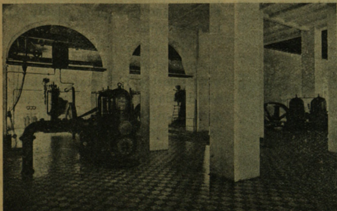
Stacja pomp, oddział górny Fot. zakł. J. Lachowicza.
