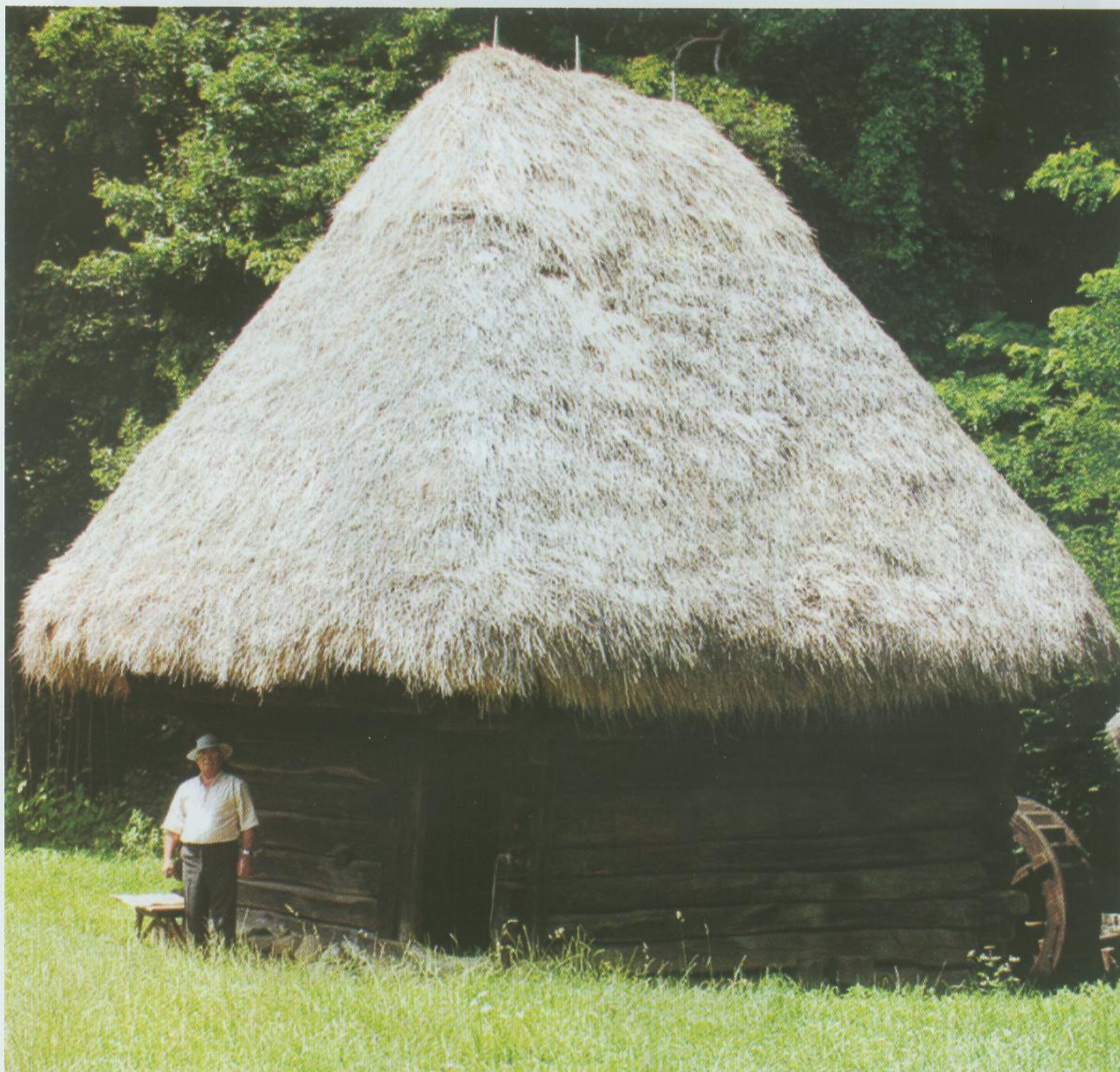
Vedere generală moară
