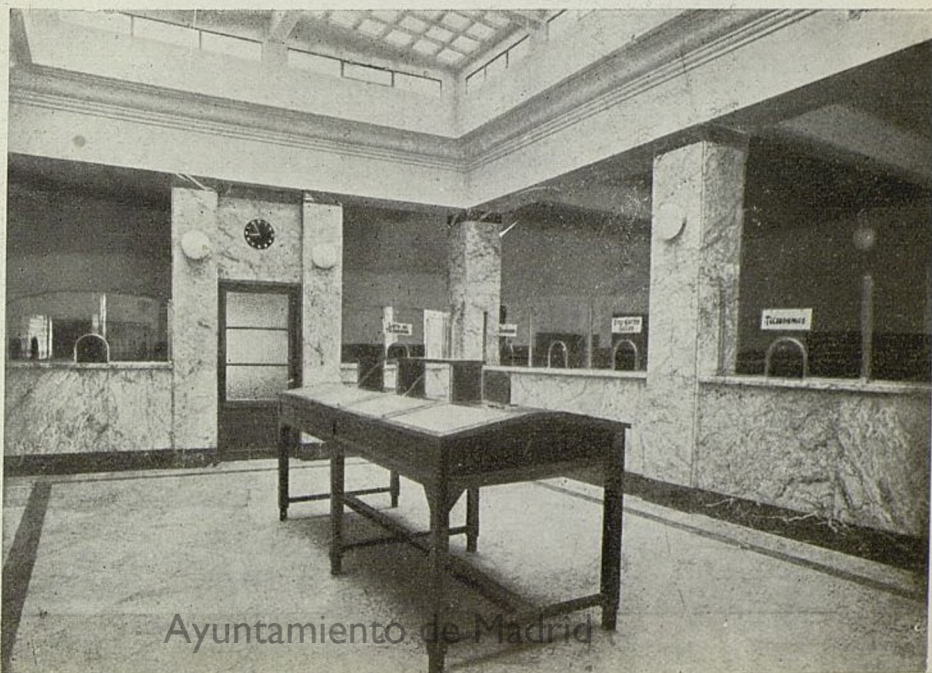
Vestíbulo de la Casa de Correos y Telecomunicación
