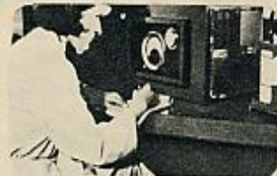
Los tejidos son jabonados y lavados en frío y caliente y después sometidos a corrientes de aire a distintas temperaturas para medir su velocidad de secado.
