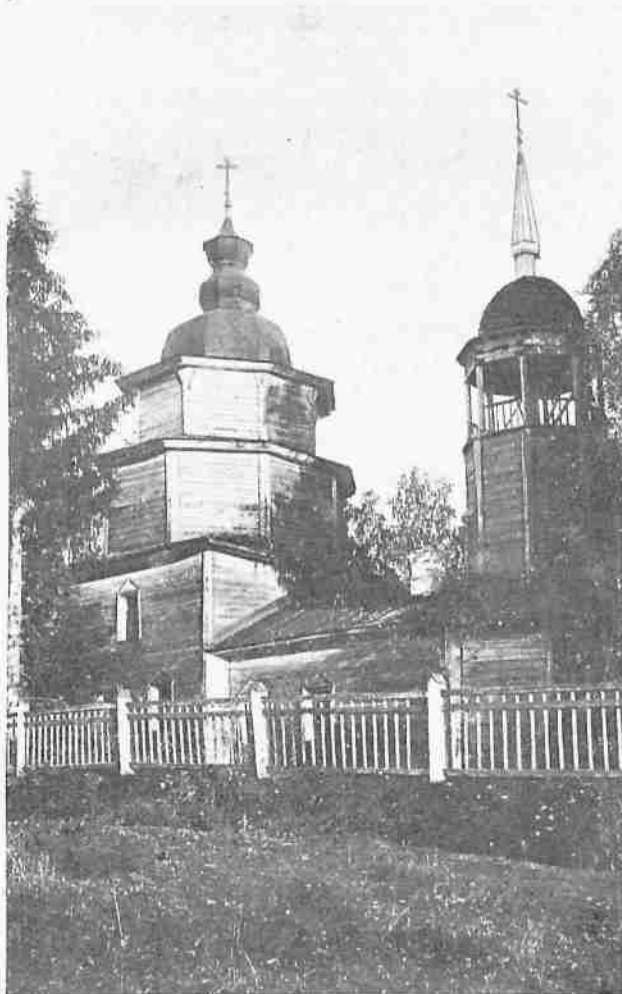
Деревянная церковь XVIII в. в Грязовецком уезде Вологодской губ.
