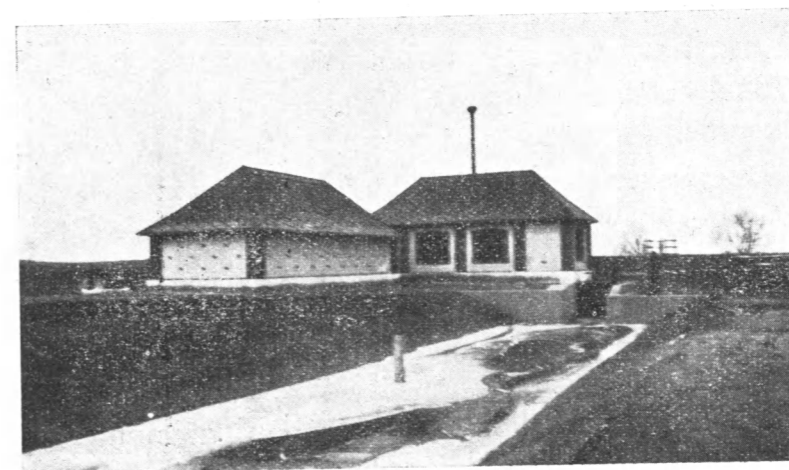
17. ábra. A cseréstótoroki szivattyutelep a tápláló csatorna felől.
