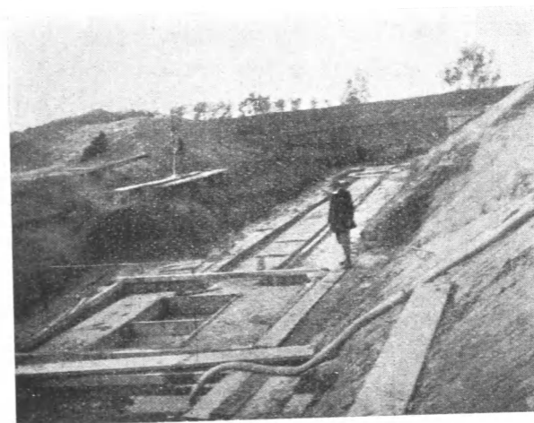
25. ábra. A cseréstótoroki szivattyutelep építése 1927 évben. A csővezeték beton alapozása.
