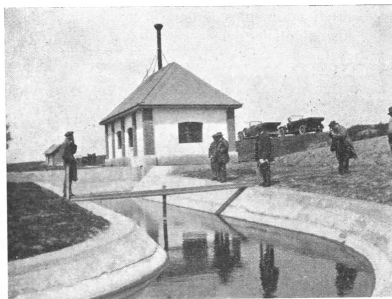
11. ábra. A kemecei szivattyutelep betonnal burkolt tápláló csatornája. (Szabó Nándor miniszteri tanácsos felvétele.)
