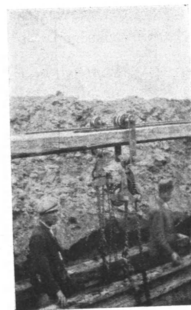
34. ábra. Vasbetondeszka burkolat foglaló gerendáinak elhelyezése a becréti szivárgón 1927 évben.
