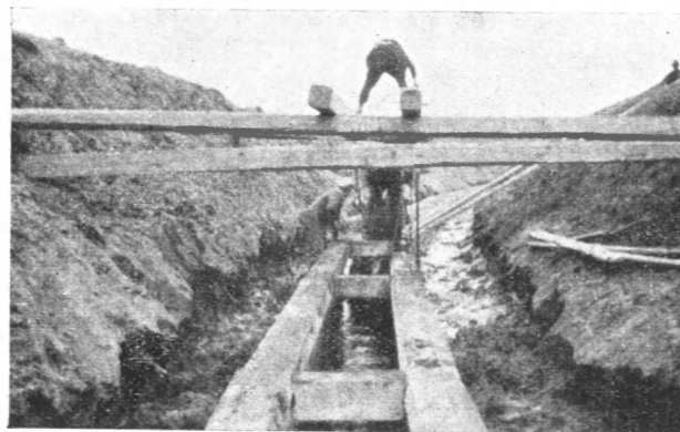
35. ábra. Vasbetondeszka burkolat fogláló gerendáinak elhelyezése a becréti szivárgón 1927 évben.
