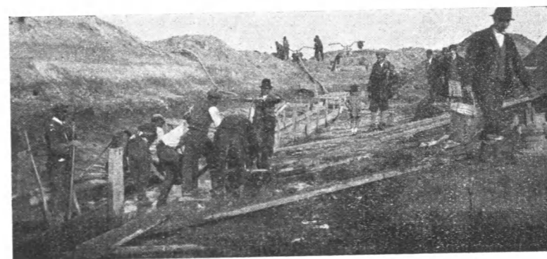
19. ábra. Betonozás a sényői főfolyás pápaházi vízbujtatójának építésénél 1928 évben.
