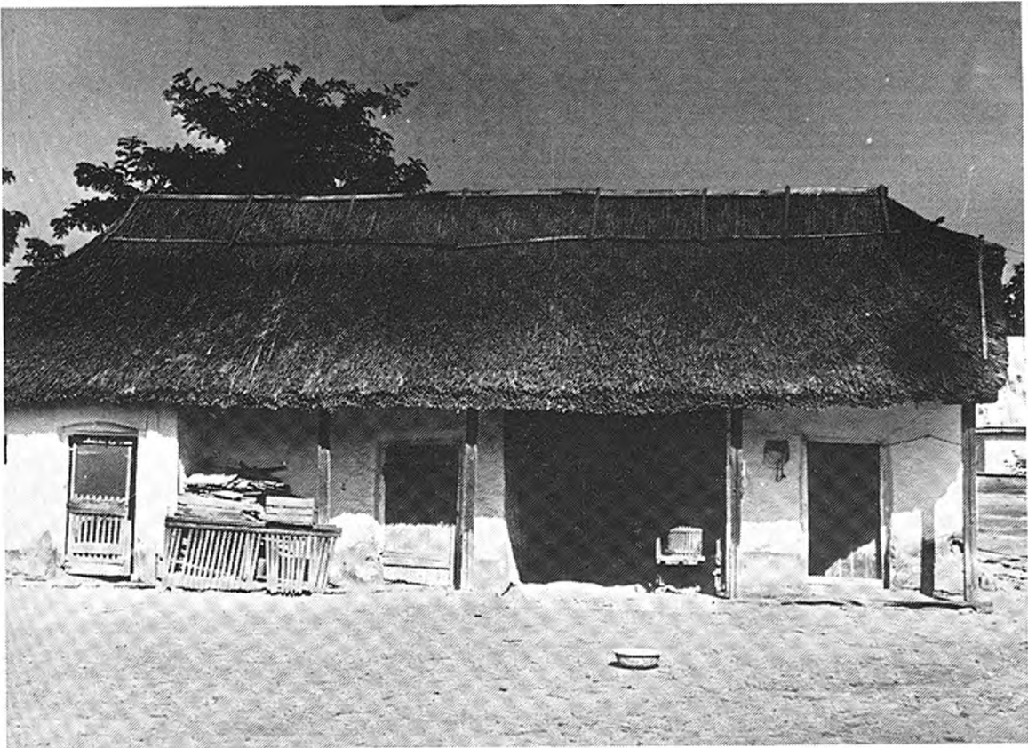
1. kép. Istálló kerékszínnel és katonaoállal egybeépítve. Lakóházra emlékeztető forma. A nádtetőt deszkaszegés rögzíti. Létavértes (Nagyléta), Új u. 14.
