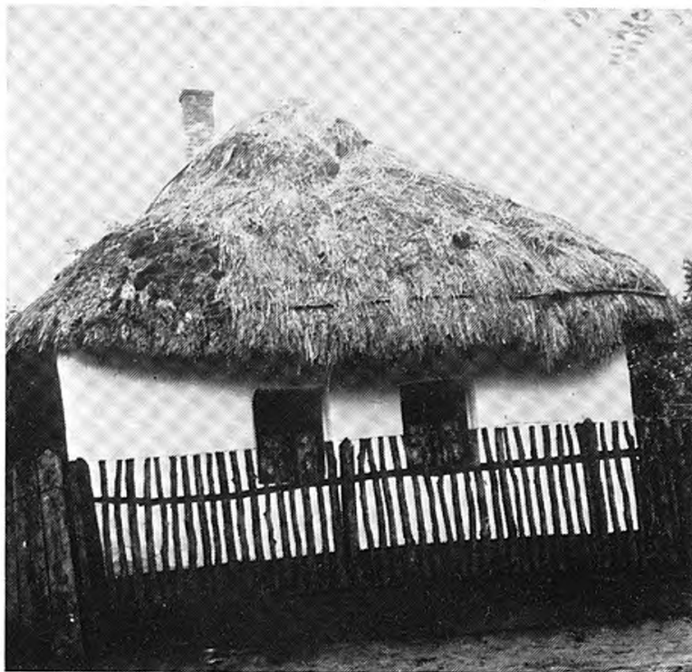
13. kép. Vámospércsi ház (Rákóczi u. 12.) XIX. sz. közepe. Kétablakos, eiökertes, hasítványkerítéses, zsúpos
