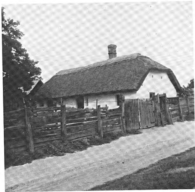
15. kép. Hajdúhadházi ház (Lázár Vilmos u. 3.), XIX. sz. közepe. Istállóval egybeépített, tornác nélküli, pitvarablaka van
