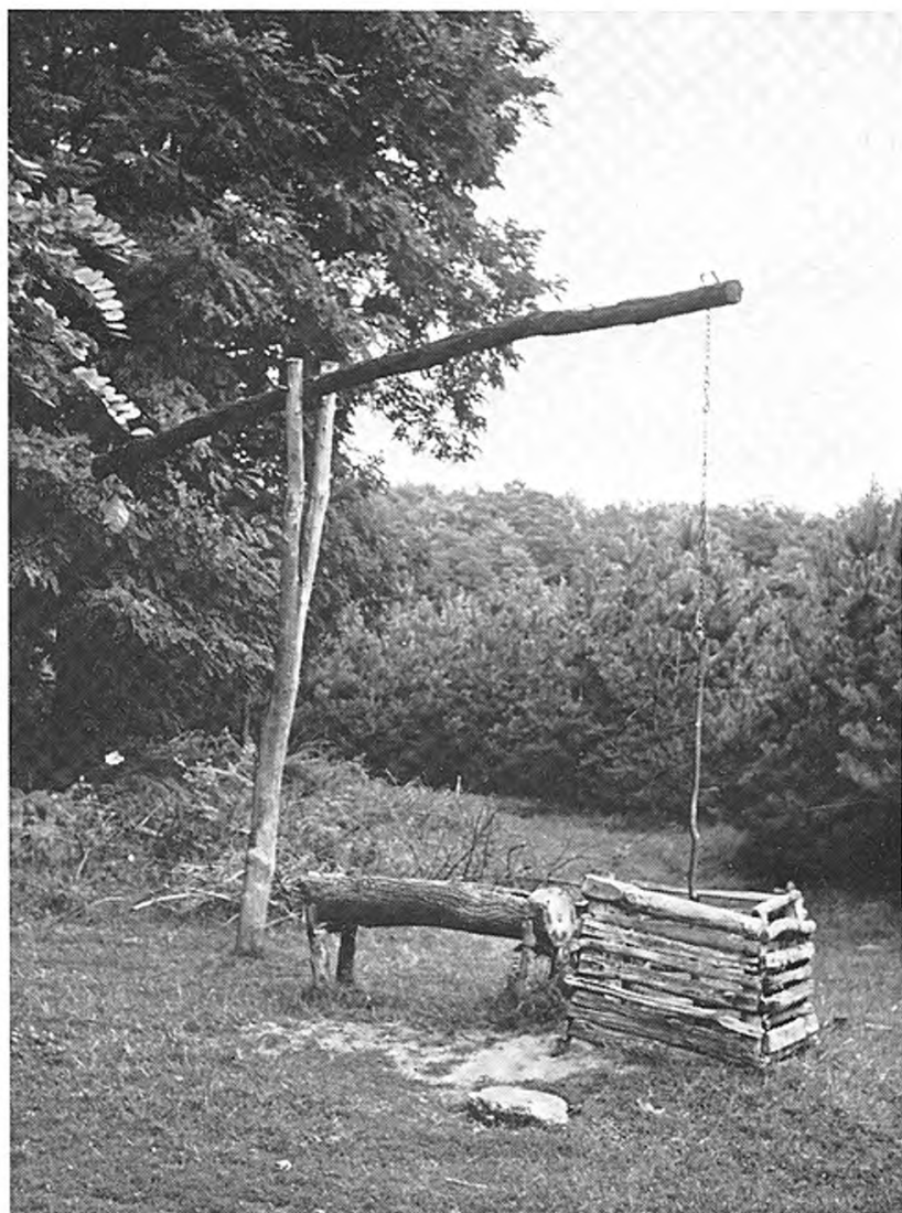
35. kép. Kút, kétágú kútágassal, favályú, fagárgya. Hosszúpályi, Erdőoldal
