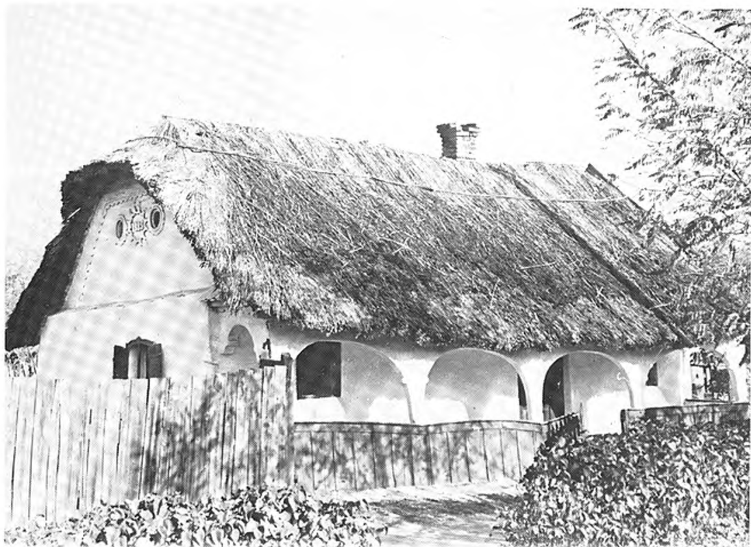
10. kép. Régi ház, sárboltozatos, ámbitusos tornáccal. A tűzfalon sárból nap-diszítés, 1835-ös dátum. Pocsaj, Fő u. (Lebontották!)
