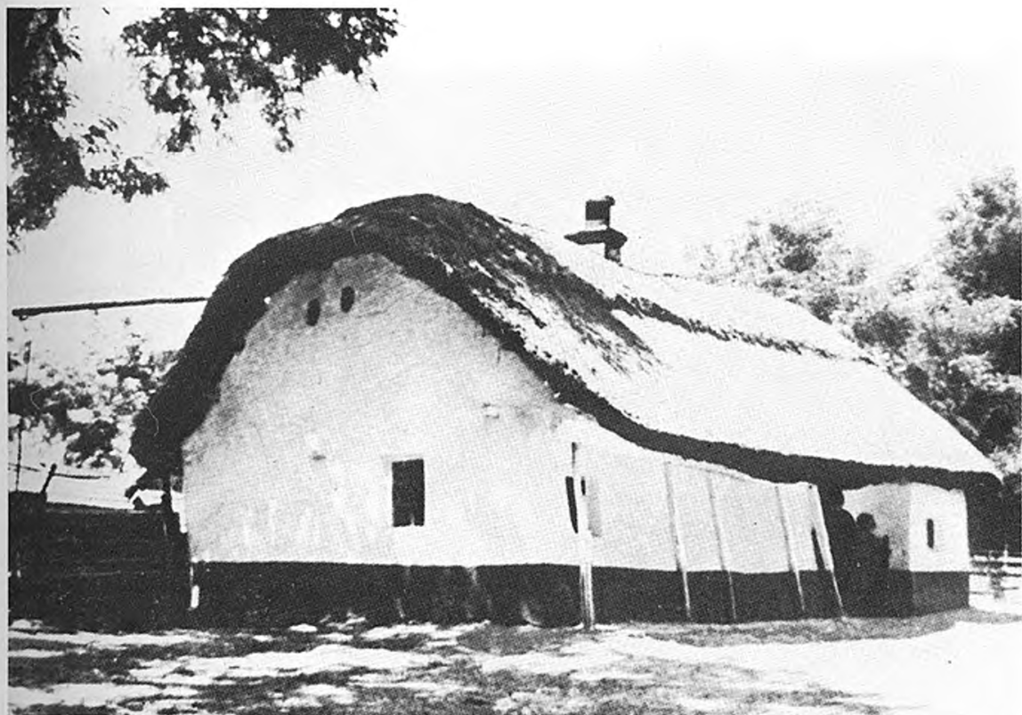
9. kép. Komádi (Hajdú-Bihar m.). Bogárhátú lakóház (Tóth János: Népi építészetünk hagyományai. 1961. 201. o.)
