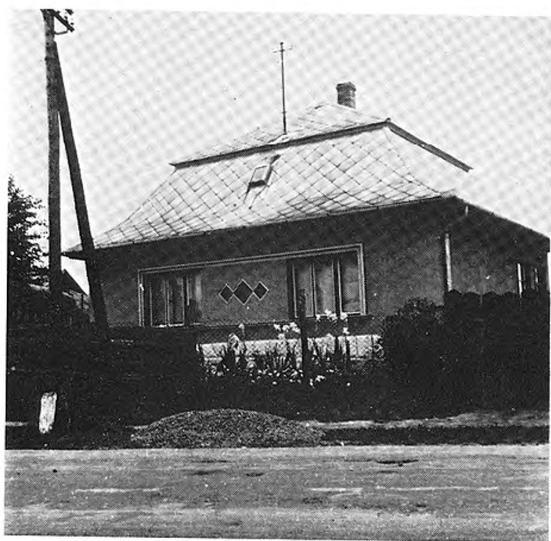
27. kép. Vámospércsi ház (Tanácsköztársaság u. 70.), épült 1961-ben. Anyaga téglá, vályog. Álmanzárdtetővel, palafedéssel
