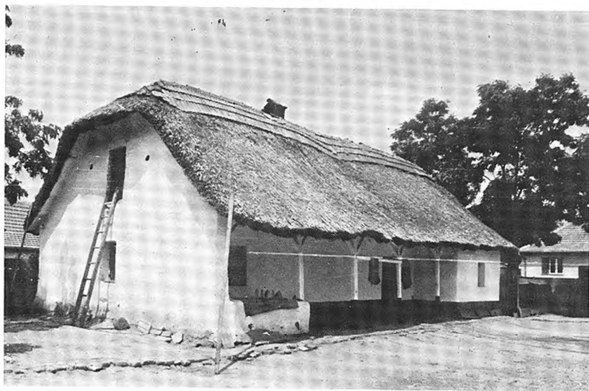
14. kép. Jellemző sárréti ház kontyolt nyeregtetővel és díszítetlen tornácoszlopokkal. Berettyóújfalú. Dám L. felv.
