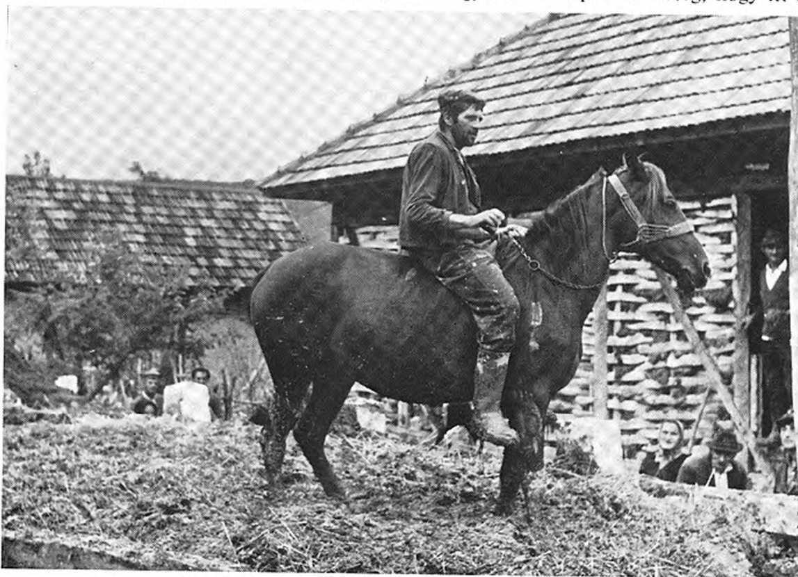
3. kép. Épülő favázas, paticsfalú ház. A szükséges sarat lóval tapostatják. Roşia. Bihar m. Románia
