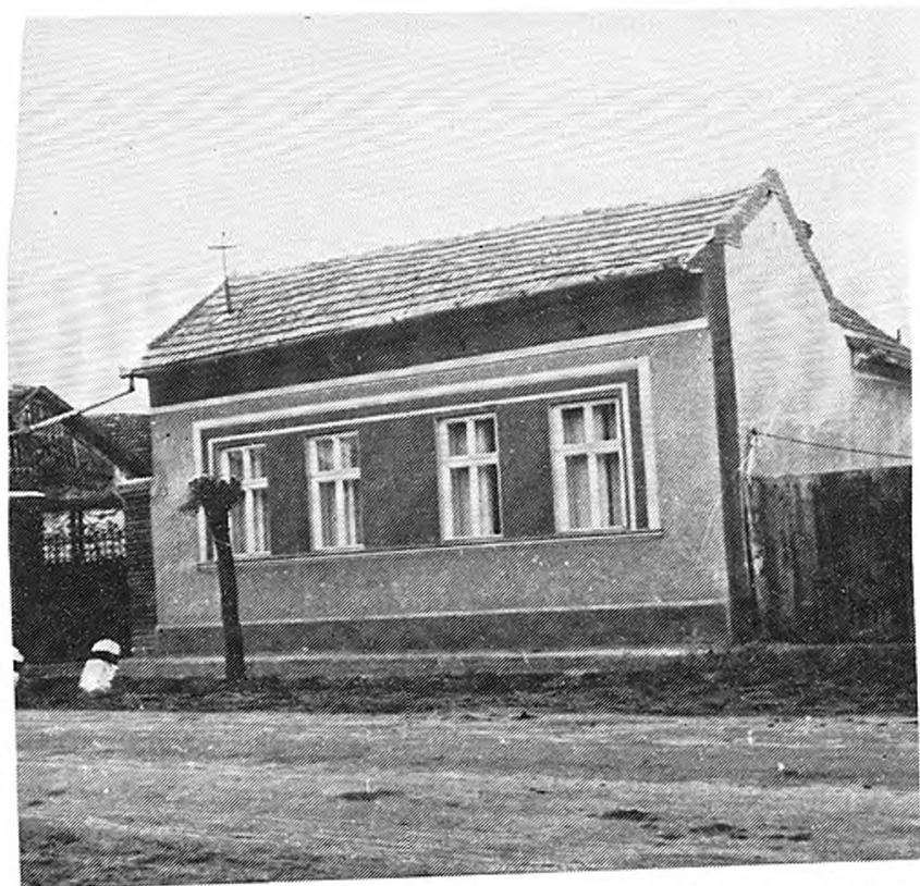
6. kép. Vámospércsi ház (Tanácsköztársaság u. 43.), XX. sz. eleje. Utcai oldalhomlokzatos, a padlás előtt magasított
