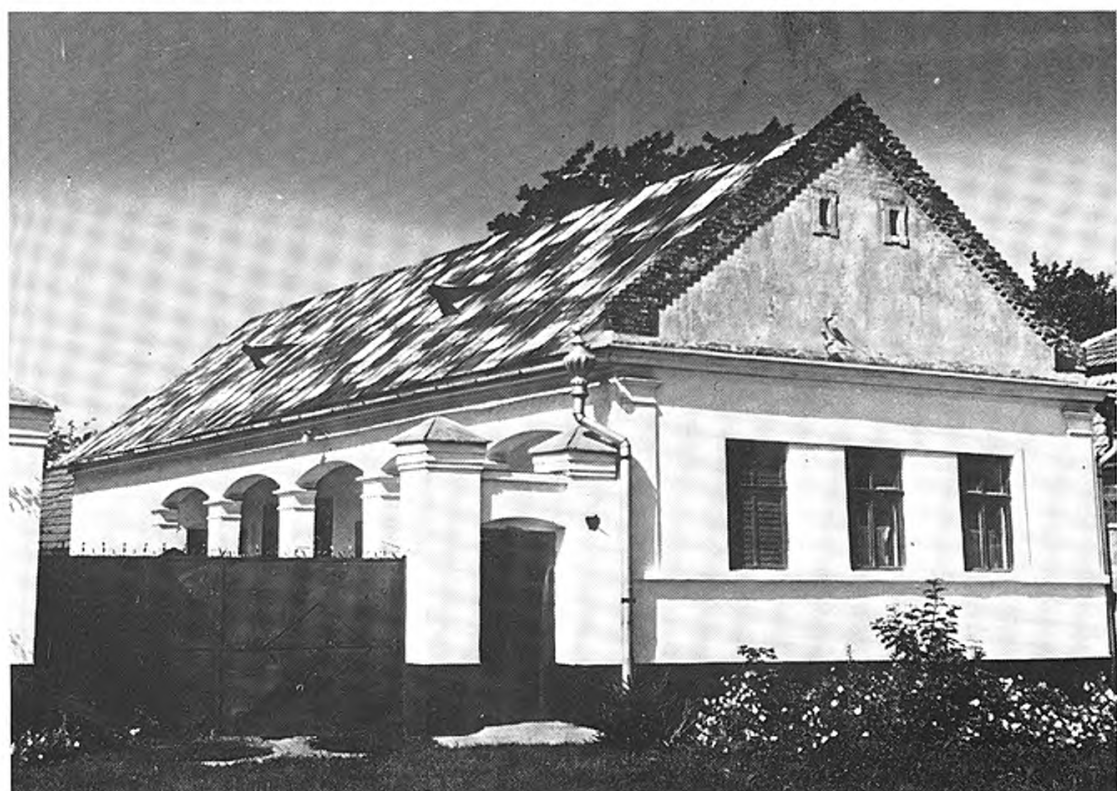
15. kép. Új stílusú, zárt tornácos, kőlabas ház, téglafal, bádogtető. Építette Kathó Elek, 1938 körül. Hosszúpályi
