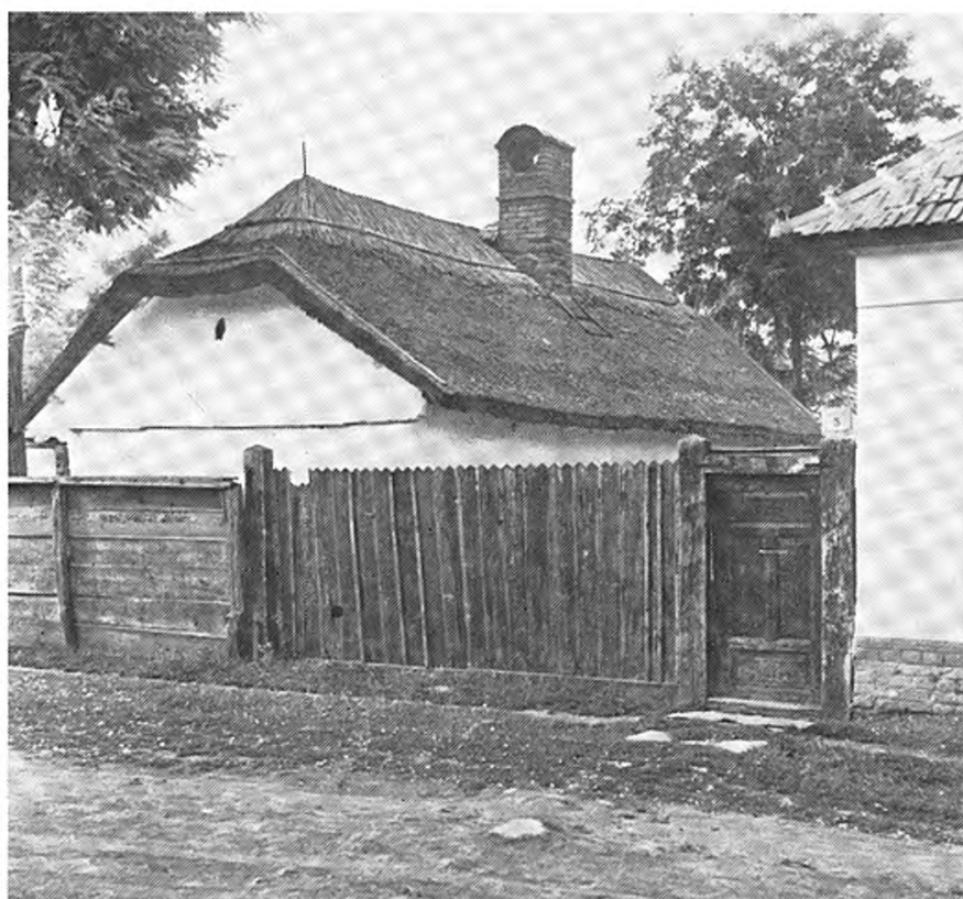
20. kép. Hajdúnánási ház (Dankó u. 5.), XX. sz. eleje. Náddal kontyosan fedett, fedett kéményű vízvetővel
