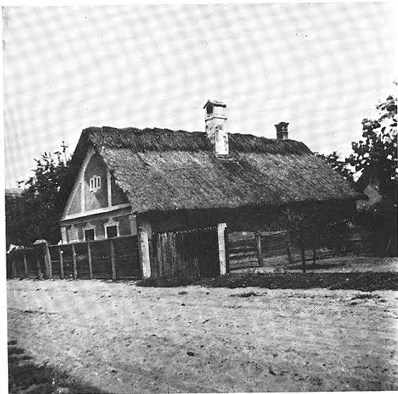
16. kép. Hajdúhadházi nemesi ház (Zrínyi M. u. 13.), XIX. sz. eleje. Vályog, széles, fedett kéményű ház, tűzfalán szép vakolatdíszekkel
