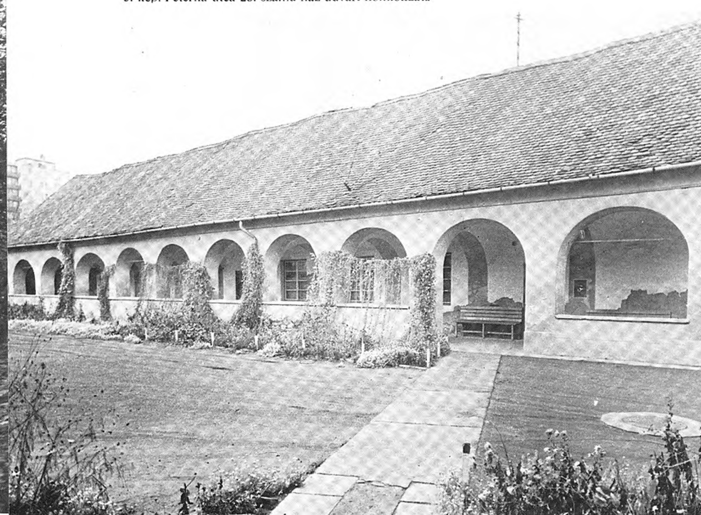
3. kép. Péterfia utca 28. számú ház udvari homlokzata
