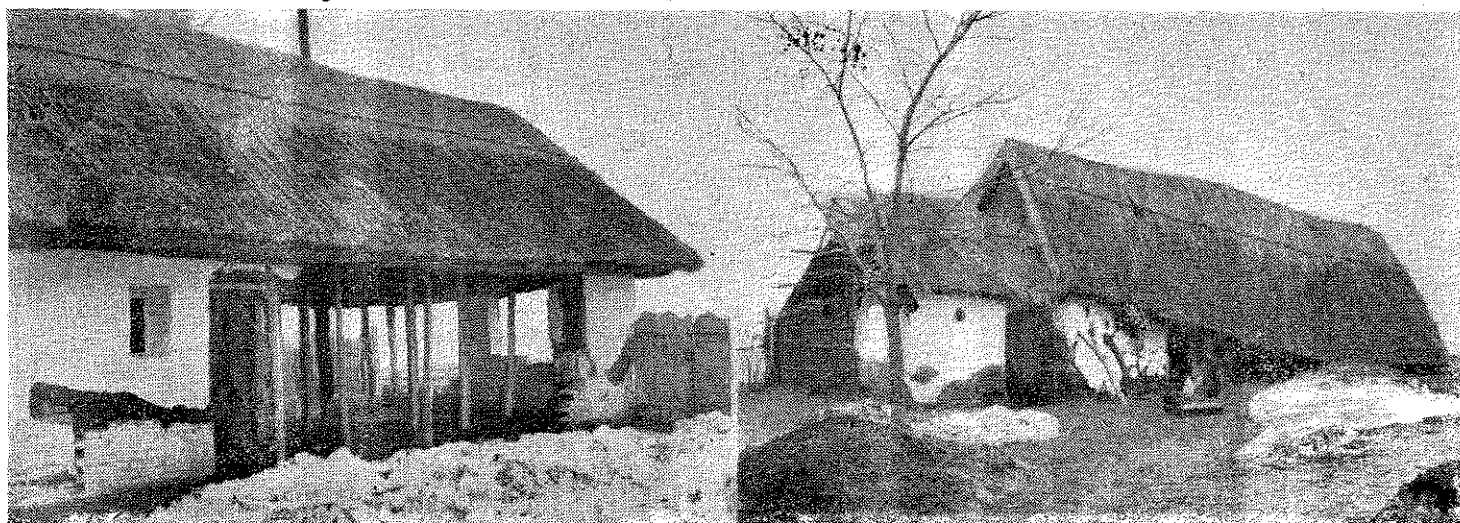
Helyesen és helytelenül alátámasztott épület
