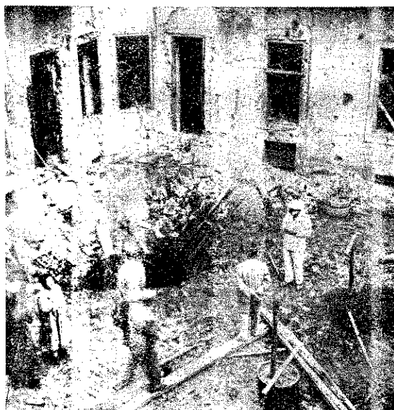
A 3. számú bomba becsapódása. A bomba mélyen a talajba fúródott, azt nem feszítette szét s így a bomba repeszdarabjai kartácsként lövelltek ki az ágyúcsőszerről tyukból.
