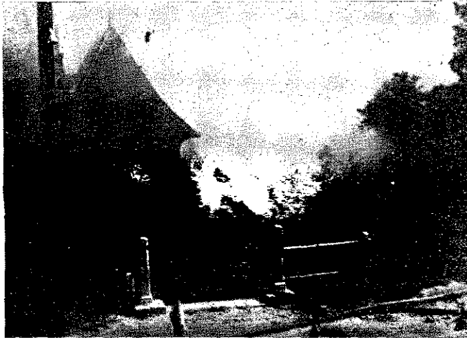
1. ábra. Az égő kioszk az első két sugár megszerelése után. A jobboldali részen a füstfelhőben dolgoznak a tűzoltók.
