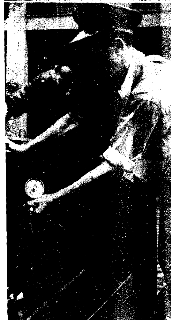
A motor felülvizsgálása során nem hagyhatjuk figyelmen kívül a gyertyák minőségét és a kompressziót, — ezeket műszerrel ellenőrizzük.
