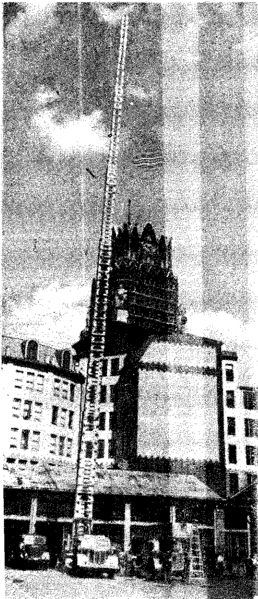
A 45 m-es gépjármű tololétra teljesen kihúzott állapotban.
