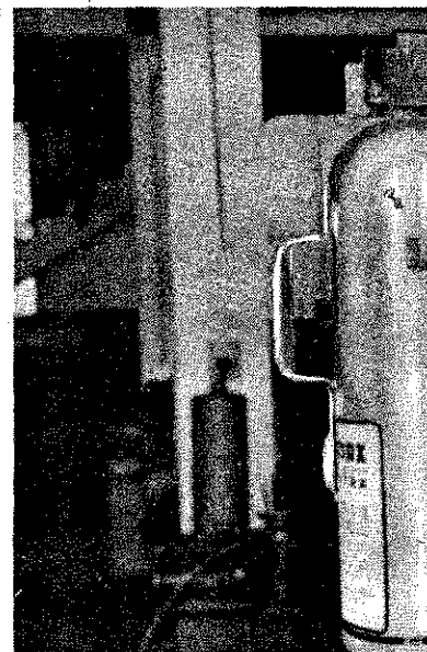
A gázzal oltó kézi tűzoltókészülék elhelyezése így helyes: védőkupakkal elzárva.
