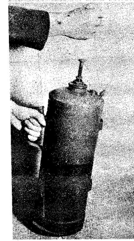
Ezzel oltó kézi tűzoltókészülék te- akasztása és üzembehelyezése.
