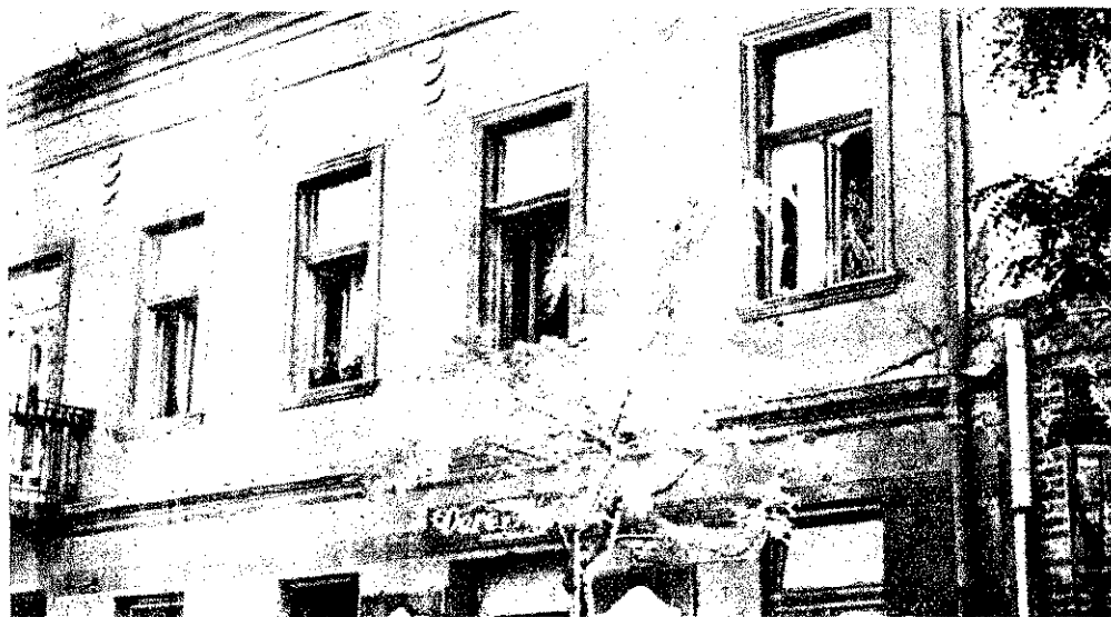
Legfontosabb intézkedés: az esetleg bekövetkező robbanásra való tekintettel a szomszédos épületeket, tereket, utcákat ürítsük ki és az ablakok kinyitására gondoskodjunk. A képen jól láthatjuk, hogy a kinyitott ablakok épen maradtak, viszont a csukott ablak betört.
