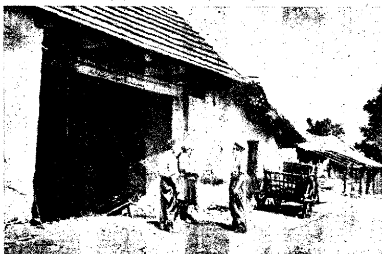
Az érdi elvtársaink szabadnapjukon sorra lárták a község házeit, beszélgettek a dolgozókkal a tűzrendszert fontosságáról, s az észlelt hibákat mindjárt a helyszínen ki is javították.
