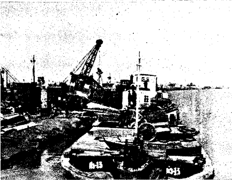
Nap-nap után az egész Szovjetunió területéről rengeteg különböző gép, építési anyag és szerszám érkezik a Turkmen-Föld csatorna építéséhez. Ugyancsak ezután történik gondoskodás a munkásokat végző dolgozók legbiztonságosabb ellátásáról is.
