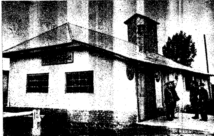
A Budakalászi üzemi tűzoltó elvtársaink társadalmi munkával épített laktanyája
