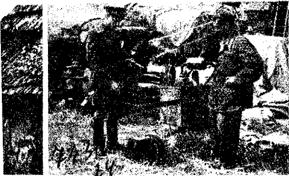
Ezzel a szikrafogóval csak akkor lehet tovább dolgozni, ha előbb megtisztítja a kőzomót — mondja az ellenőrző elvtárs.
