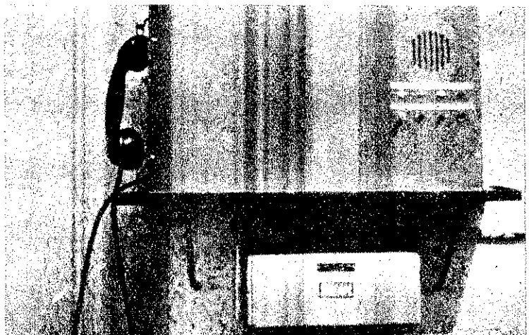
Az „alarmofon” tűzjelző berendezés
