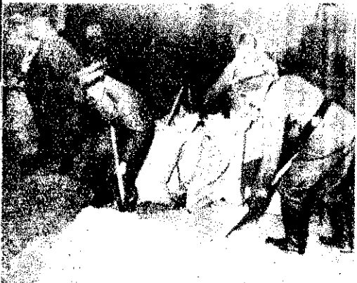
Kiskunlacházán földkitermeléssel és gát-építéssel kezdtek a munkát a kivonult tűzoltóegységek
