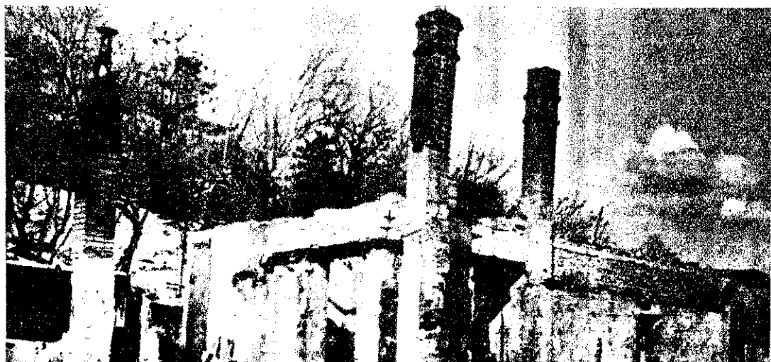
A leégett épület
