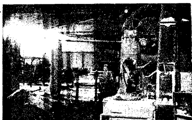
Faaprító üzem a papírgyárban: légszivő-berendezés szállítja az aprítókat a silóba
