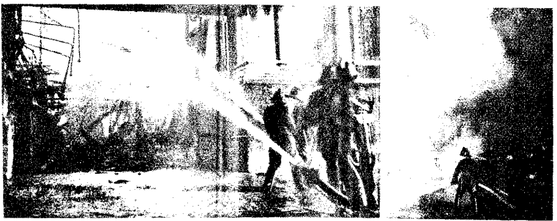
A londoni tűzoltók a baromfi piac vasvazát hűtik. (A kép a tűz keletkezését követő 28. órában készült.) A földalatti tűz oltására — a füstelvezetés céljából felbontott nyíláson keresztül — vízködsugarakat használtak
