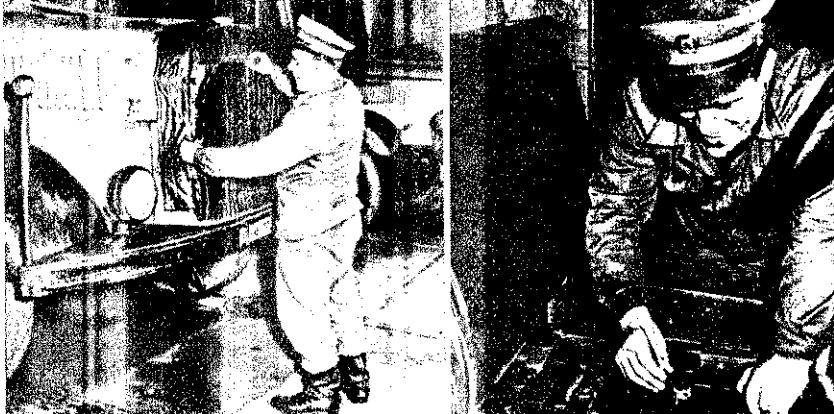
A hűtőtakaró felszerelése és az akkumulátor-sav sűrűségének ellenőrzése is fontos feladatunk
