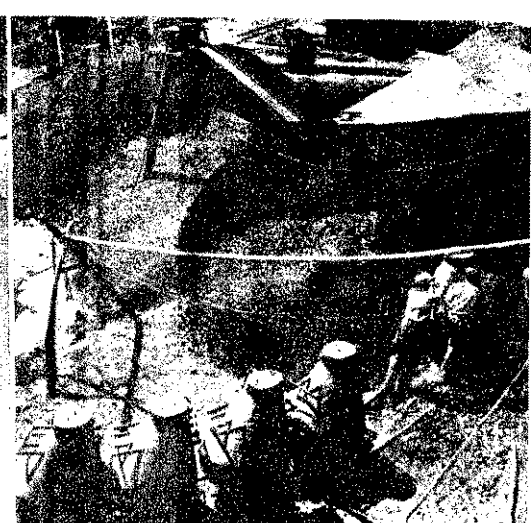
A faszen lehűtésére szolgáló, sínen mozgatható vastartályok
