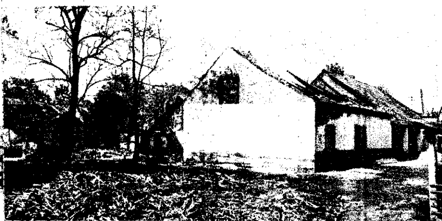
Ez a gazdasági épületrész égett le utoljára. Mögötte már nád- fedeles épületek sora következik
