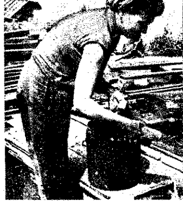
Ragasztott lemezek lángmentesítése felületi kezeléssel
