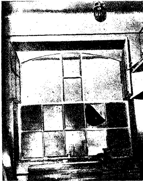
Nagy ablakfelület biztosítja a gázok esetleges „kifújását”
