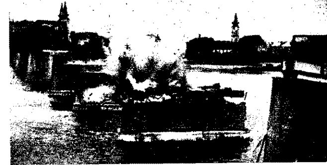
bbantással lazítják a lebontásra kerülő Kossuth-híd pilléreit
