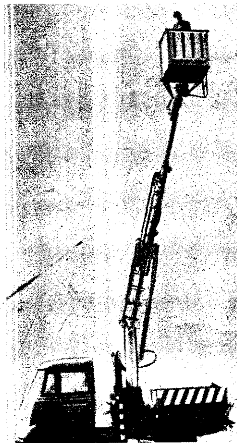
A Budapesti Ipari Vásárról is ismert felépítményű gépkocsit mutat be képünk. Amerikában újabban mindinkább növekvő mértékben használják ezt a gépkocsi-típust a tűzoltóságok is. Az állvány összes mozgása az ott tartózkodó személy által irányítható
