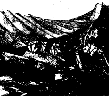
az összeomlott, csővázás és hullámlapokkal fedett raktár egy részlete látható
