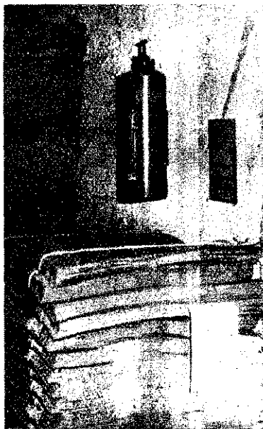
Aminek nem szabadna megtörténnie: Egy eltörlesztött vízzelöltő s egy vízhordó — üresen...
