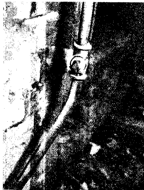
A képen jól látható a porlasztóhoz vezető olajcső elzáró szelepeinek nyitott állása
