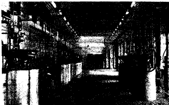
PH—TIKKO szénsavval oltó berendezés a Volkswagen-erkek festő és fényező üzemének festékek előkészítő ter-ében. A keverőtartályok és szivattyúk szénsavoltó be-ndezéssel védettek
