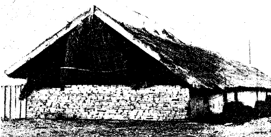
gy már valamivel biztonságosabb. A sajhídvégi Rákóczi Tsz istállóira is felkerültek a villámhárítók...
