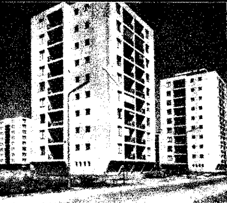
nyors ütemben épül a lágymányosi lakótelep. Felvételiükön az újonnan elkészült 9 szintes öntöttbeton épületek
