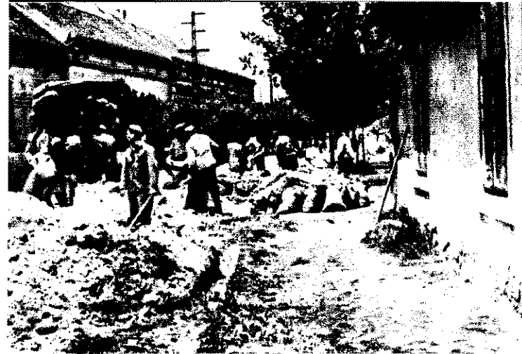
A Tolbuhin utca egész hosszában folyik a védekezés; homokzsákokkal tömítik a szivárgások helyét...
