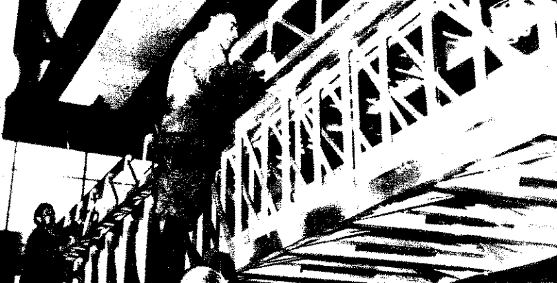
Keresően zárta az évet a központi javító műhely. Képeinken az 1965. évi utolsó munkálatok egy-egy mozzanatát örökítettük meg: Nagy Péter és László Károly főtörzsőrmesterek beemelik a nagyjavítás alatt álló tolelétra utolsó tagját — Kurucz Lajos törzsőrmester a Tűzoltó Múzeum részére készülő modell állványát készíti
