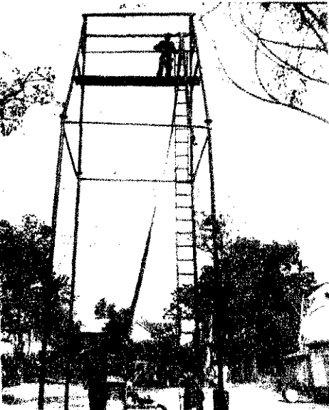
A megyei parancsnokság műhelyesének segítségével így oltották meg Kisvárdán a tömlőmosást és -száritást
