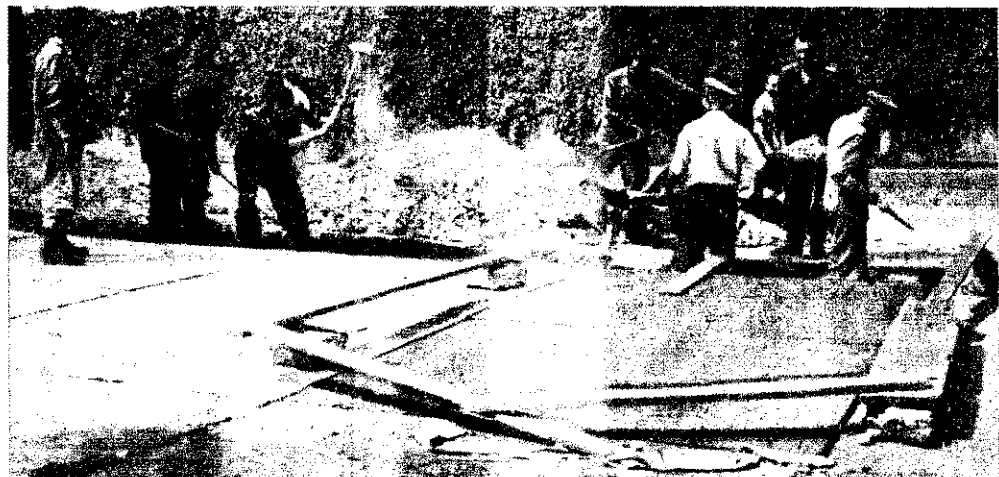
A fűzfői parancsnokság beosztottai felajánlásuk keretében új betonkifutót is építenek
