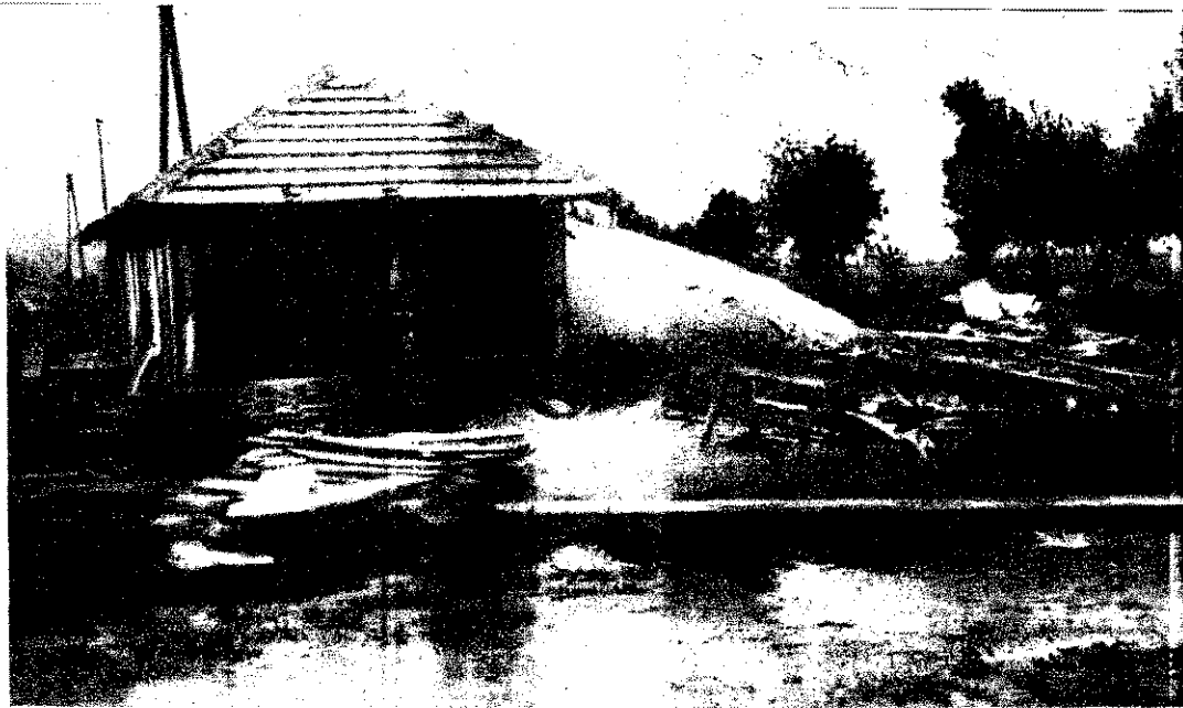
A fűrészpor és fahulladék tárolásának tűzrendészeti szabályairól, mint a képen is látható, alaposan megfeledeztek a lipóti Petőfi Tsz-ben. Alig hihető, hogy a tárolás jelenlegi formája növeli a fából készült „gatter” biztonságát...
