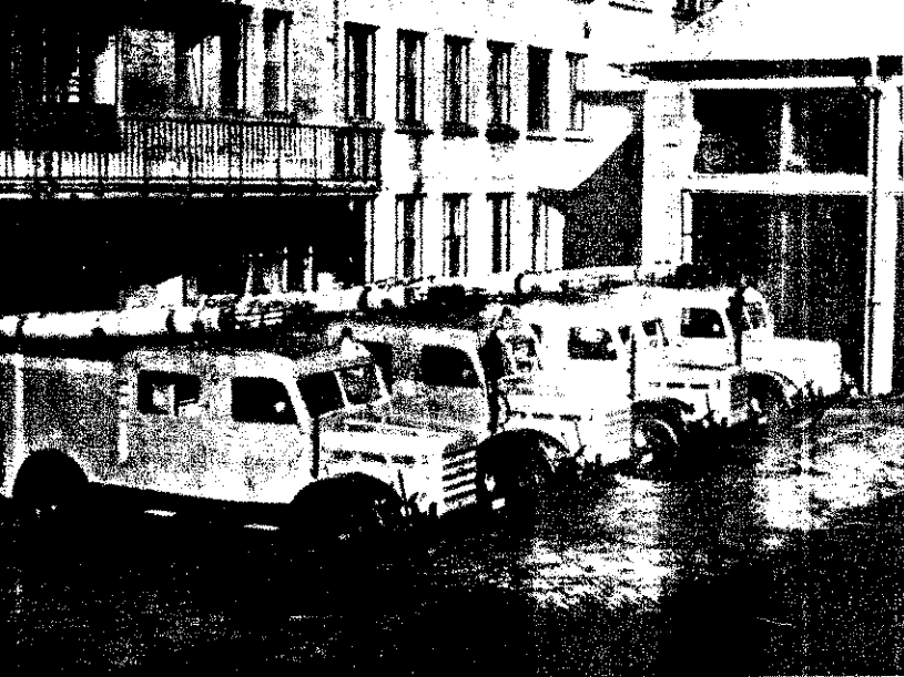
Ezeket az áramfejlesztő szereket CSD 420-as típusú, nagyjavításra beütemezett gépjárművekből alakították át — egyidejű felújítással
