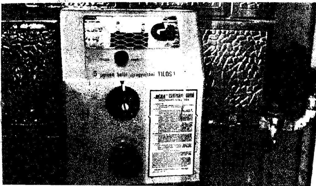
Igy szerelték fel a Héra cserépkályha-gázégőt
