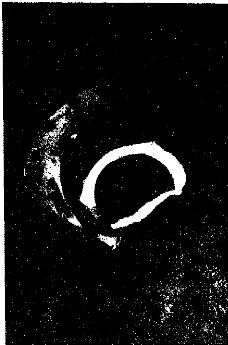
nyomásemelkedés következtében leszakított porcelán
