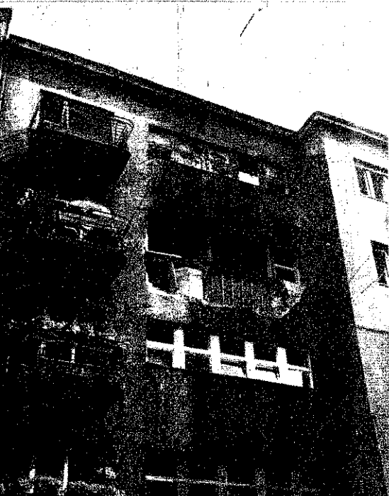
A robbanás következtében omlott parapettfal.
