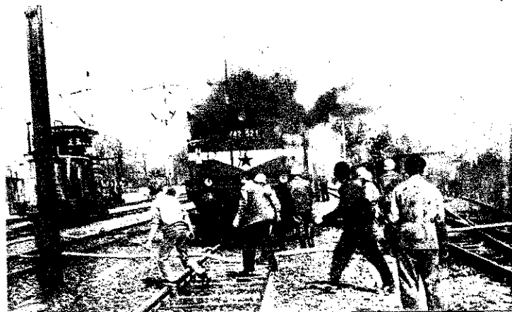
Az utasok elhagy-ják a szerelvényt. A mozdony előtti földelő rúd bizto-sítja az áramtala-nítást
