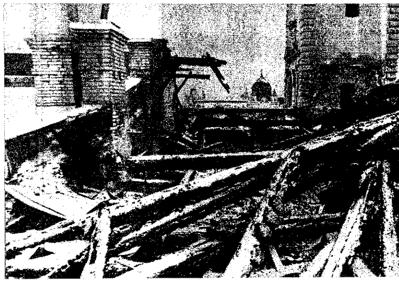
A kiégett gerendából. A tűz feltételezett keletkezése X-szel jelölve
