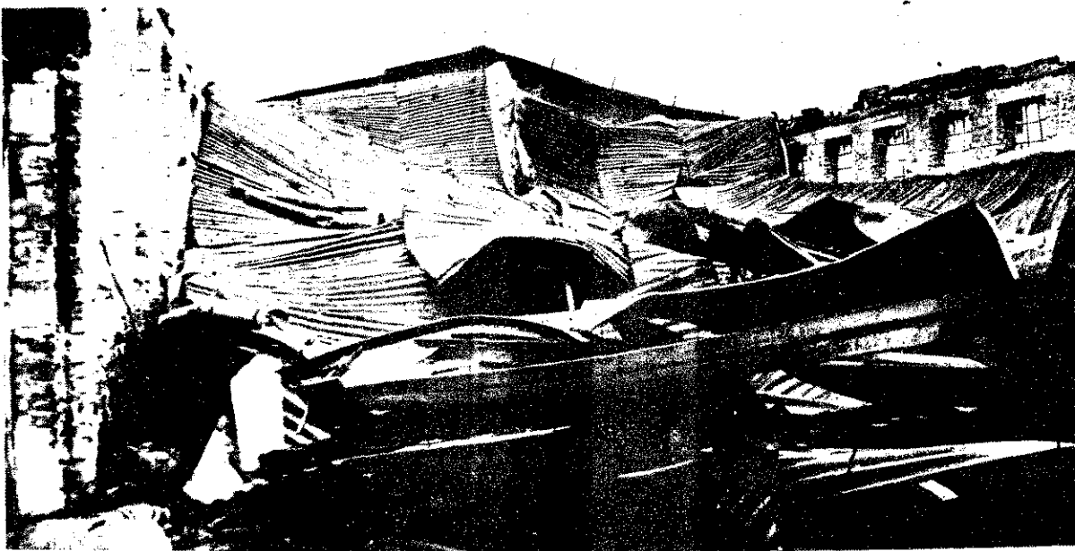
A festőfal felé szakadt tetőzete
