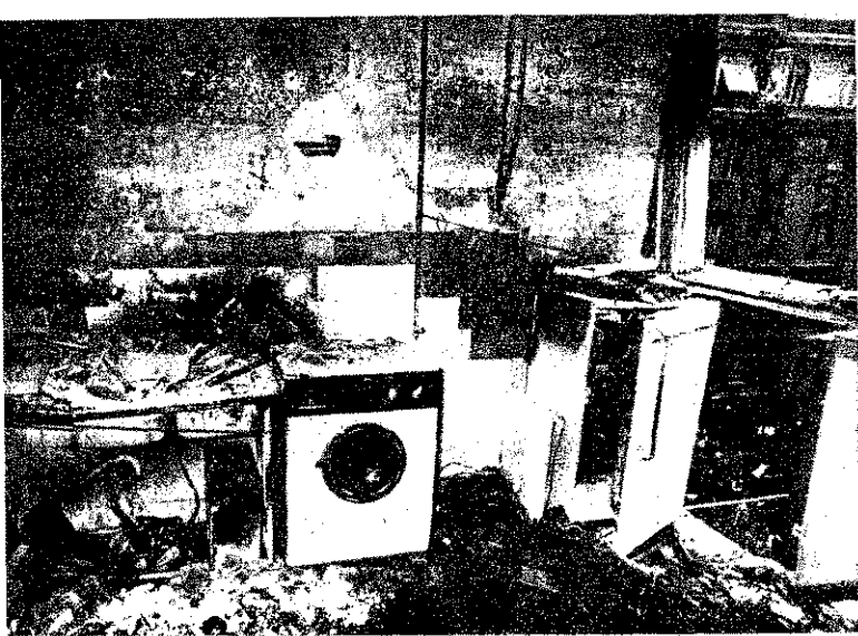
A konyha: a robbanás középpontja. Az ablak melletti hűtőszekrény elektromos szikrájából robbant fel a gáz— levegő elegy.
