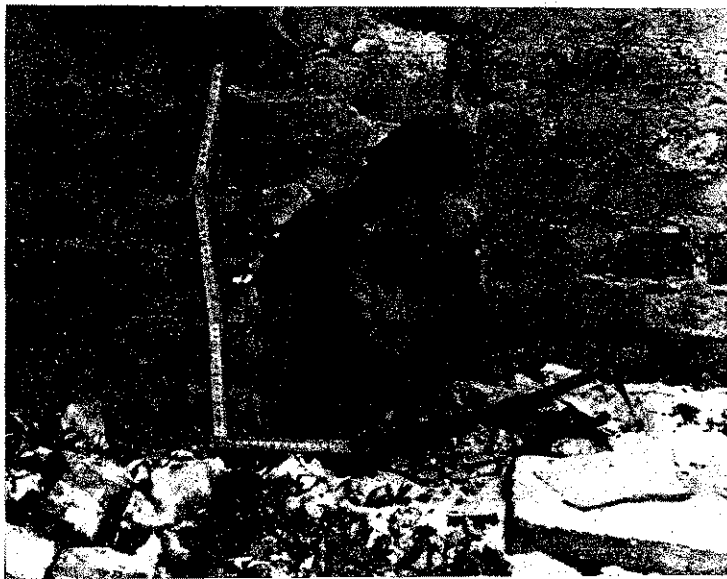
A meghibásodott kémény közléről, a gerenda kiégését követően keletkezett üreggel
