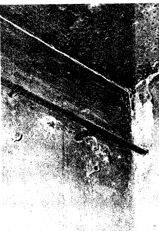
Ez a cső sem gáztömör leválasztással vezetett át a falon
