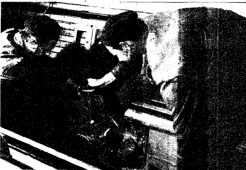
1500-as szivattyú szerelése. Erre a berendezésre is kiterjed a csere-darabos javítási módszer
