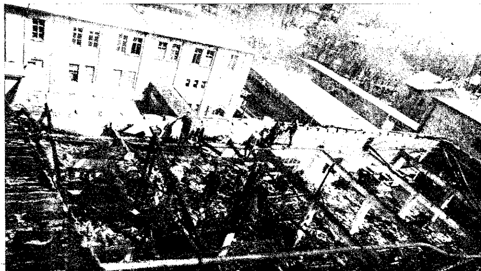
A földem tehermentesítésére el kellett távolítani a kiégett, illetve megsérült tetőszerkezeti részeket
