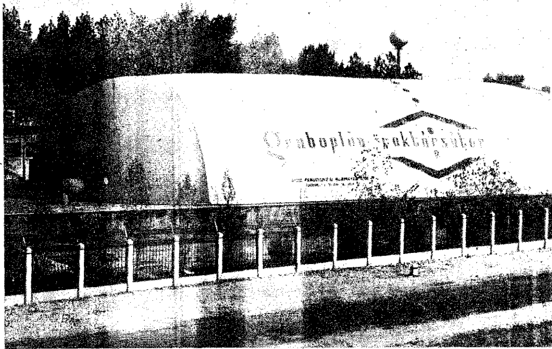
elfújható — impregnált vászomból készült — ideiglenes jellegű raktársátor
