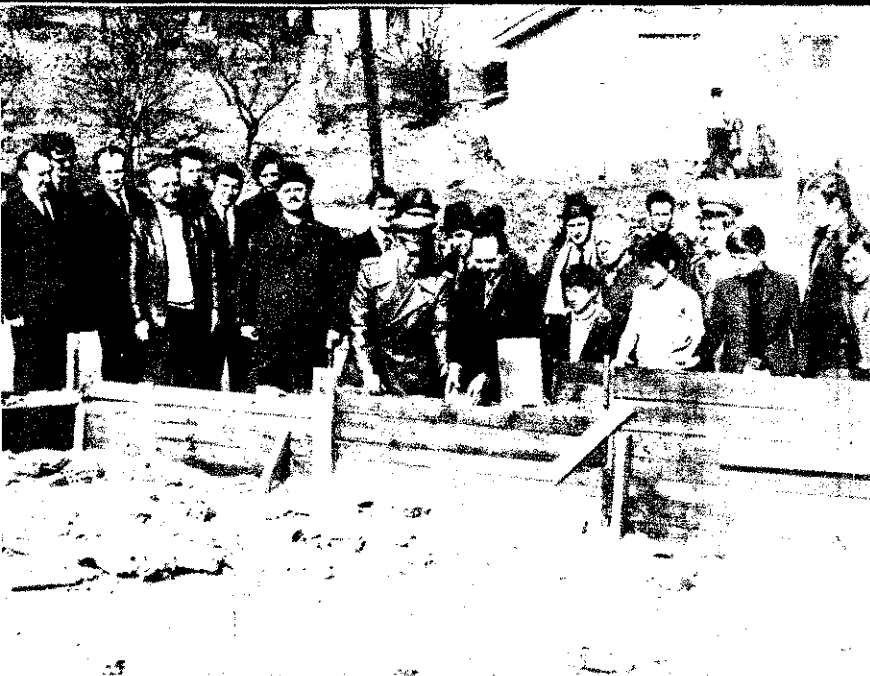
is 24-én ünnepélyes alapköletéttel kezdődött meg a százhalombattai városi testület új szertárának építése. Az eseményen részt vett Magyar Sándor ország- i képviselő is. A városi tanács 100 ezer, a megyei tanács pedig 50 ezer forint- ul hozzá a költségekhez, több helyi szerv társadalmi munkát vállalt
