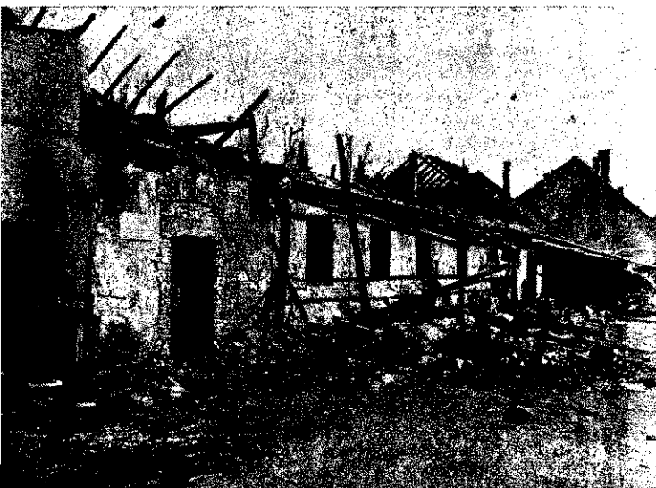
A leégett épület
