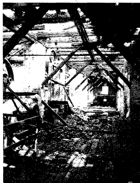
A szinteket elválasztó gerendák a tűz után
