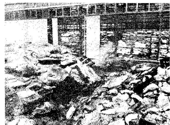
Az alumínium oldalú raktár megolvadt hiányzó elemei
