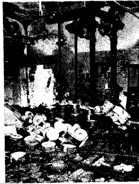
4. Ilyen volt a III. emeleten a hűtővezetékek környezete
