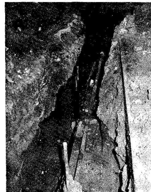
A munkásokban: jobbra a régi, balra az új csatlakozó vezeték
