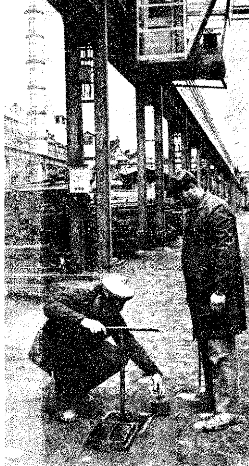
Jól bevált a módszerük: befagyás ellen télén sózás helyett zsírpárnával védik a földalatti tűzcsapok fedőlapjait
