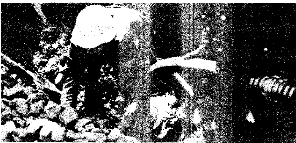
Az egyik benzintócsa felszivattyúzása
