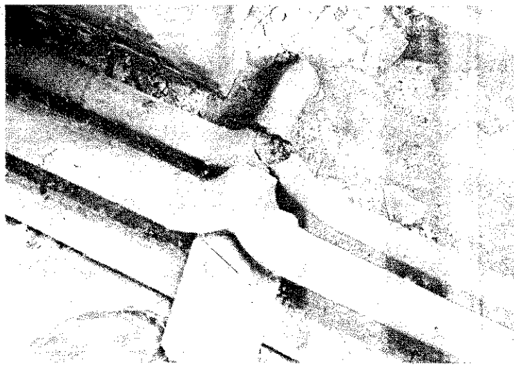
Az utolsó lángvágást itt végezték. A cső és a födémáttörés közötti rést a nyíl mutatja
