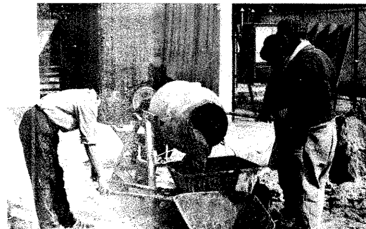
A betonkeverőt is a tűzoltók vitték
