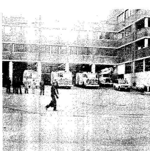
A helsinki tűzoltó-parancsnokság épülete
