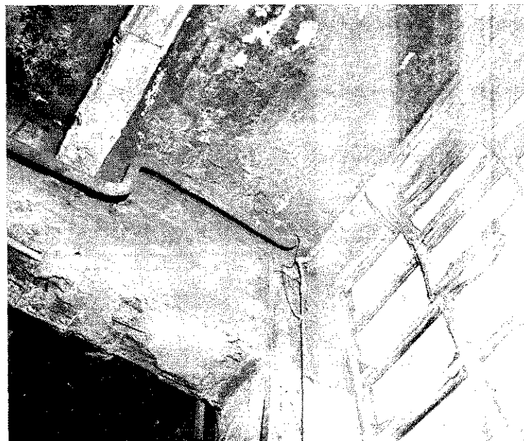
A kondenzvízeső V. emeleti közeli képe
