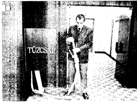
Botz Ferenc tűzvédelmi vezető a tűzesapokat ellenőrzi
