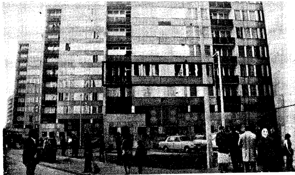
Az épület keleti homlokzata a robbanás után
