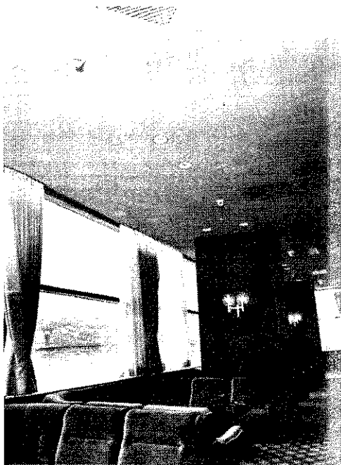
A hőérzékelők 67 °C-ra vannak beállítva
