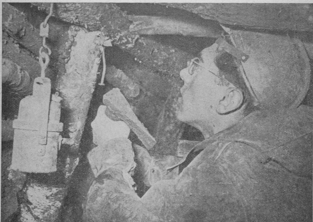
Ácsolatépítés a Kinizsi Barlangkutató Szakosztály gyökérkúti munkahelyén. (Balázs Dénes felvétele)
