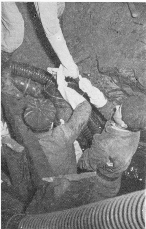
Szifonban levő törmelék kitermelése szivattyúk védelme mellett
