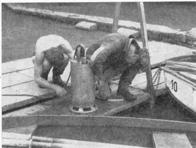
4. kép. A Flygt-rendszerű zagyszívattyú karbantartása. (A közötti képek Németh László felvételei.)
