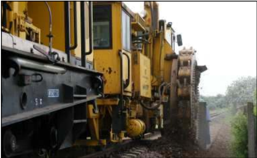
Munka közben: vágányfelújítás
