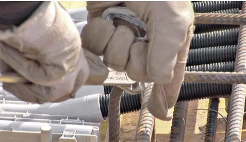
**Abb. 18** Insbesondere bei später nicht mehr korrigierbaren Maßnahmen – wie hier bei der Installation einer Betonkernaktivierung – ist die Qualitätssicherung entscheidend. Foto: IGS
