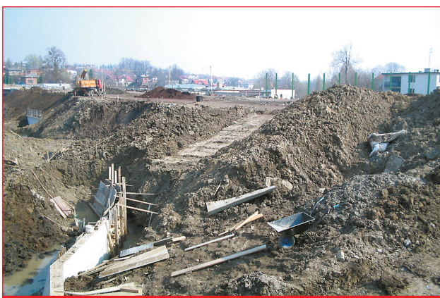
Na tym odcinku zachodniej obwodnicy miasta jest jeszcze huk roboty.
