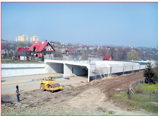
Tak zwany zielony tunel biegnący obok osiedla Piastowskiego wymaga jeszcze wykończenia.
