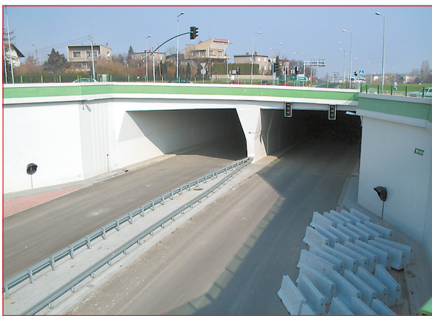
Tunel pod Hulanką jest już gotowy i czeka na podłączenie do ruchu.
