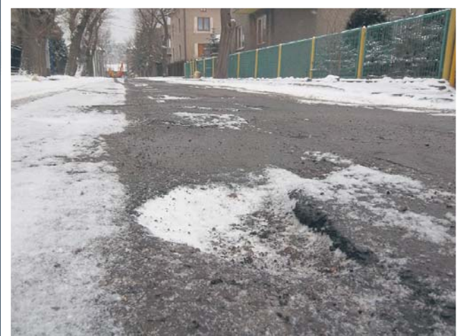
UL. DASZYŃSKIEGO 4. Dziury – ciąg dalszy
