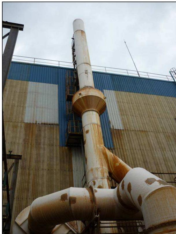
Fotografía 16: Lavador de humos de los vapores ácidos de la línea (Fuente: Elaboración propia)
