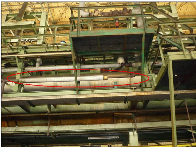
Fotografía 10: Conducción de evacuación de condensados (Fuente: Elaboración propia)
