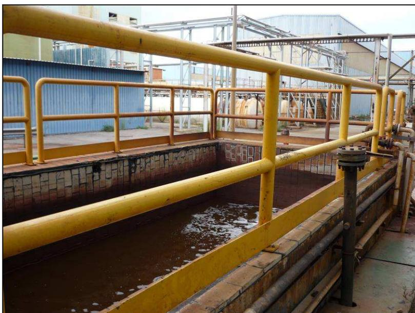
Fotografía 14: Balsa neutralizadora (Fuente: Elaboración propia)
