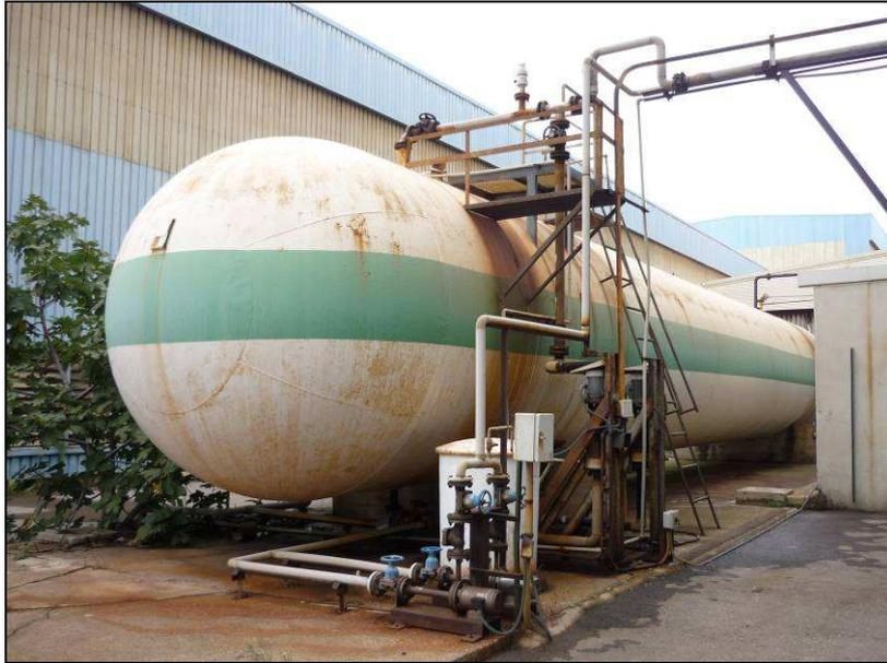
Fotografía 15: Tanque de almacenamiento de condensados (Fuente: Elaboración propia)
