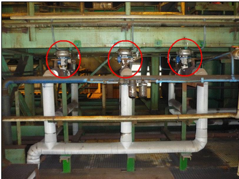
Fotografía 9: Válvulas automáticas de alimentación de los tanques de lavado (Fuente: Elaboración propia)
